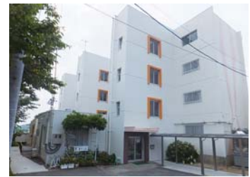
▲外壁塗装後のひめはる左奥がすてっぶ
